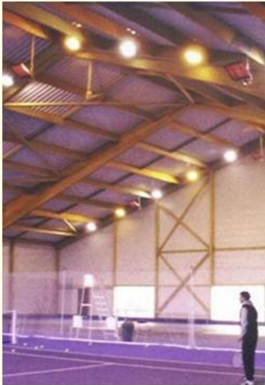
Tennis de lausanne- 600 m 2 – H = 14m - Power: 254 KW - + 20° Bei -10°
