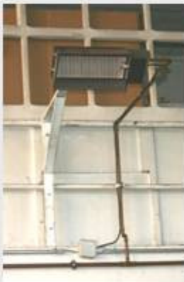
GARAGE DU FLON, Lausanne - 240 m 2 - H = 4.50m - Power: 76 KW - + 15° Bei -10°
