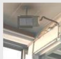
GARAGE DU SIMPLON, Renens - Env. 70m 2 4B6 - Power 10KW - +15° par -10°
